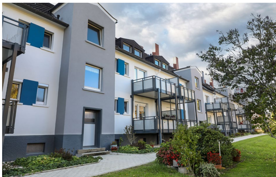
Waldecker Straße Balkonanbau, DOGEWO21 (Foto: DOGEWO21/Schaper)
