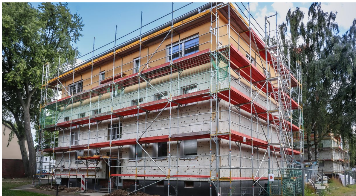
Aplerbeck Dachaufstockung DOGEWO21 (Foto: DOGEWO2/Schaper)
