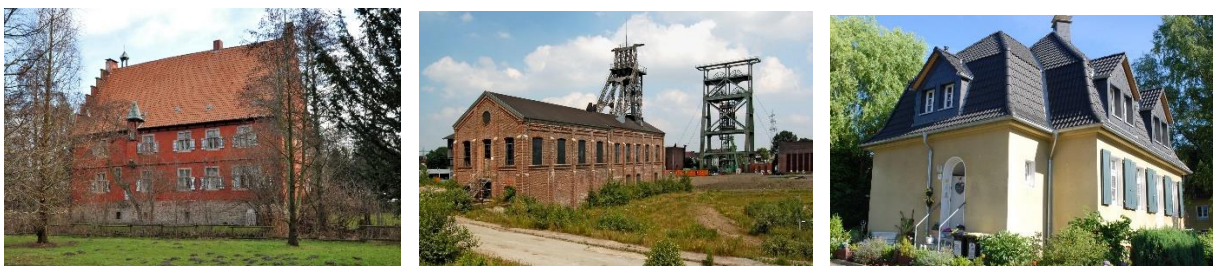
Abbildung 19: Haus Wenge in Lanstrop; Tomson-Bock mit Schalthele und Maschinenhaus; Müsersiedlung (Bogenstraße)
