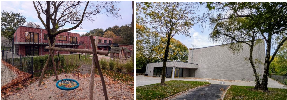
Abbildung 36: Neubau DRK TEK Buschei 28a; Neubau Turnhalle Brukterer Grundschule
