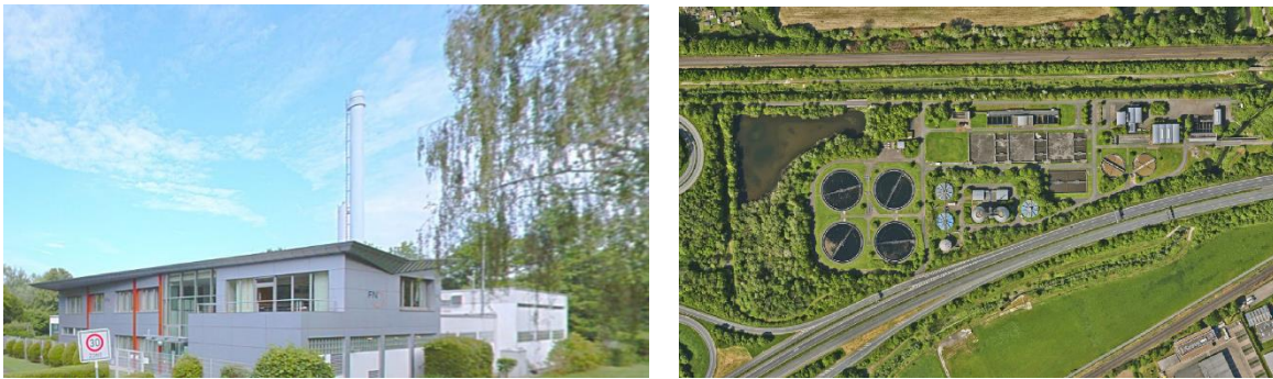
Abbildung 38: MSA-Heizkraftwerk; Kläranlage Scharnhorst
