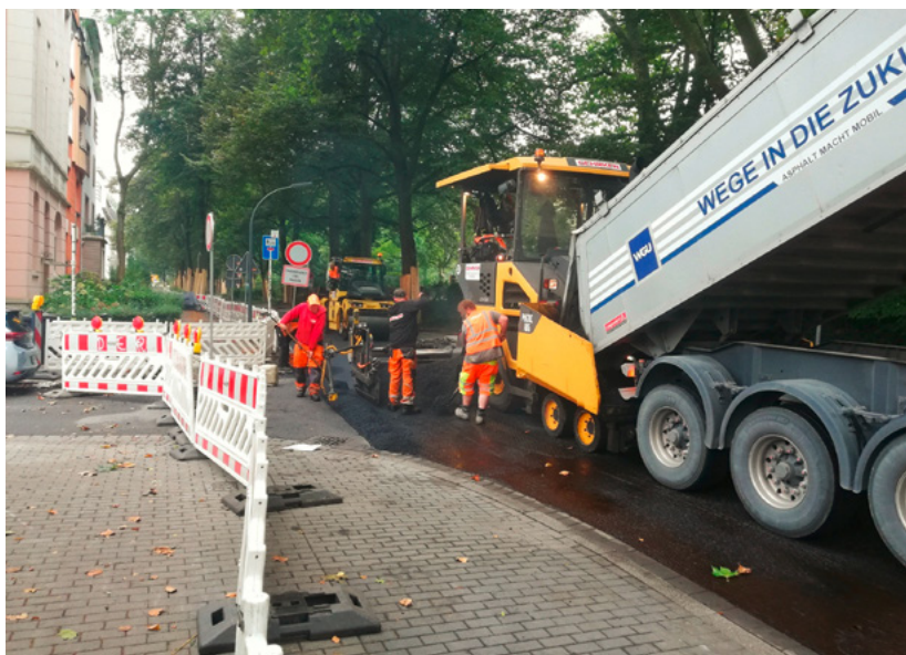
RS1: Aufbringen des neuen Asphalts.
