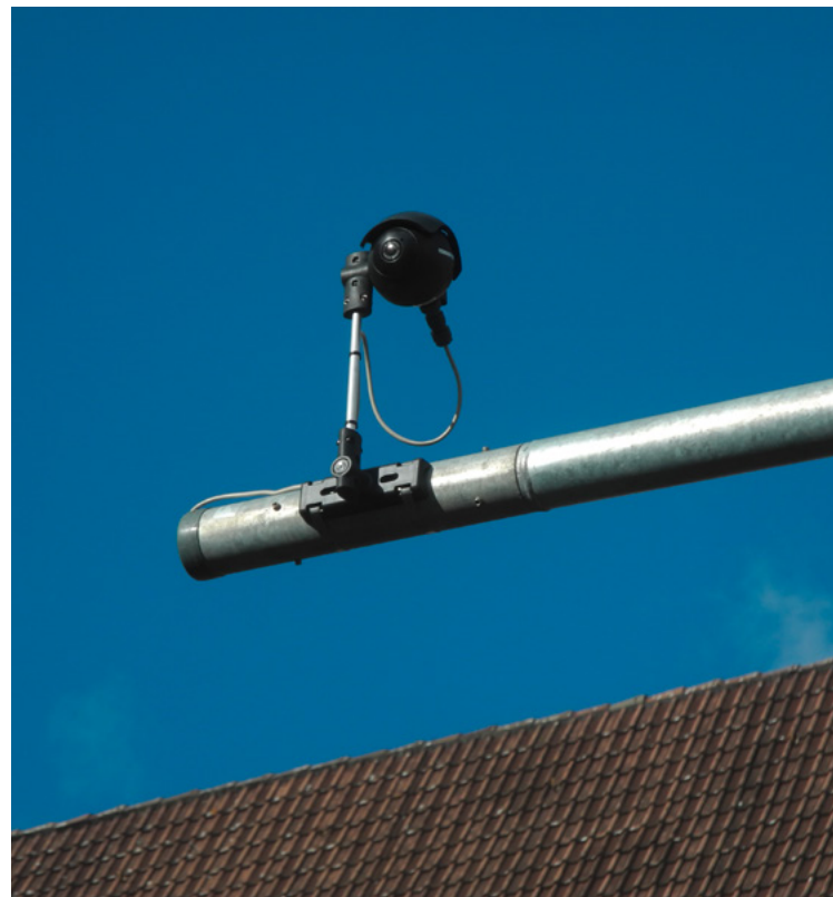
Detektor zur frühzeitigen Erfassung des Radverkehrs an der Lichtsignalanlage Joachimstraße / Rheinische Straße.
