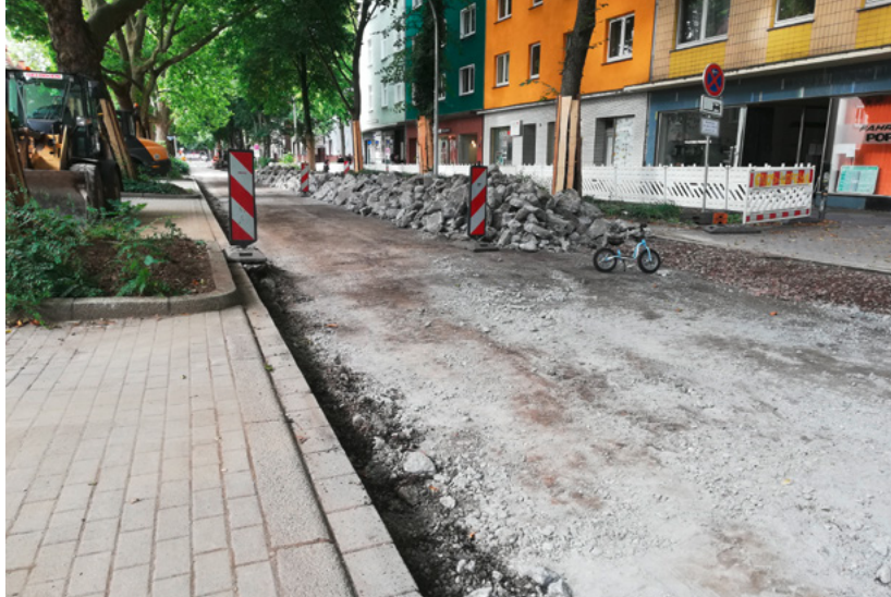
RS1: In Teilstücken musste der gesamte Unterbau saniert werden.
