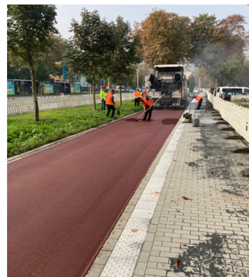
Radwall Bauabschnitt 3: Nach Pflasterung des Gehweges kommt der Rotasphalt zum Schluss.
