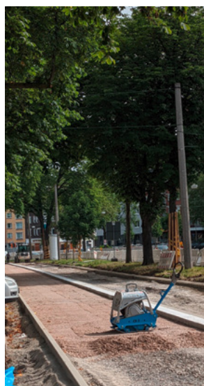
Radwall Bauabschnitt 3: Auf dem neuen Unterbau, werden die Begrenzungen gesetzt.
