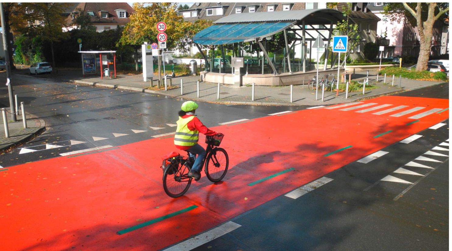
RS1: Kreuzungsmarkierung nach Leitfaden „Radschnellwegverbindungen in NRW“
